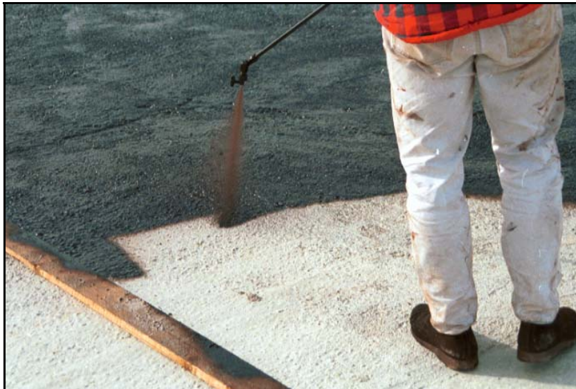
Particolare di applicazione ad airless con Icoblac
