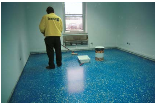
Applicazione Icofloor CL/Pur TR a rullo
