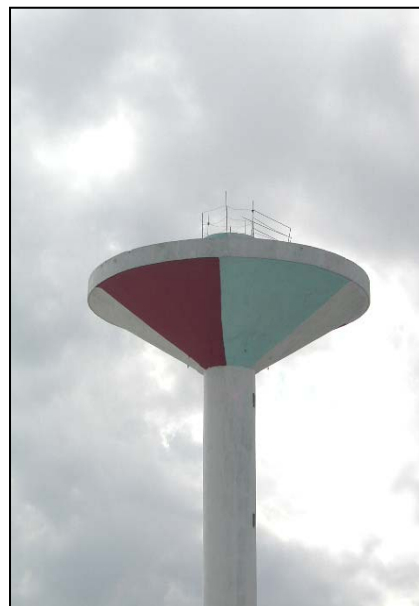
Vista esterna lavoro
