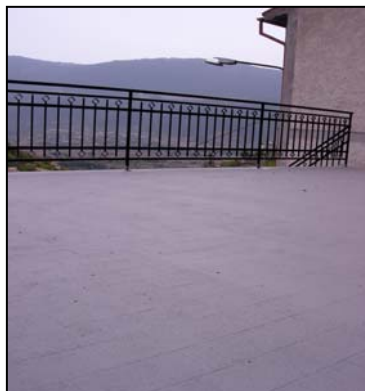
Icoper HP su vecchie piastrelle
