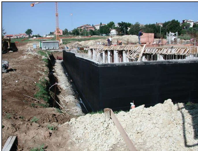
Impermeabilizzazione Muro controterra
