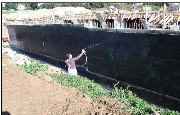
Applicazione Icofer controterra
