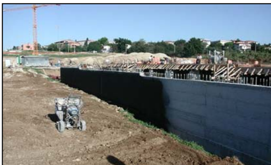
Applicazione ad airless
