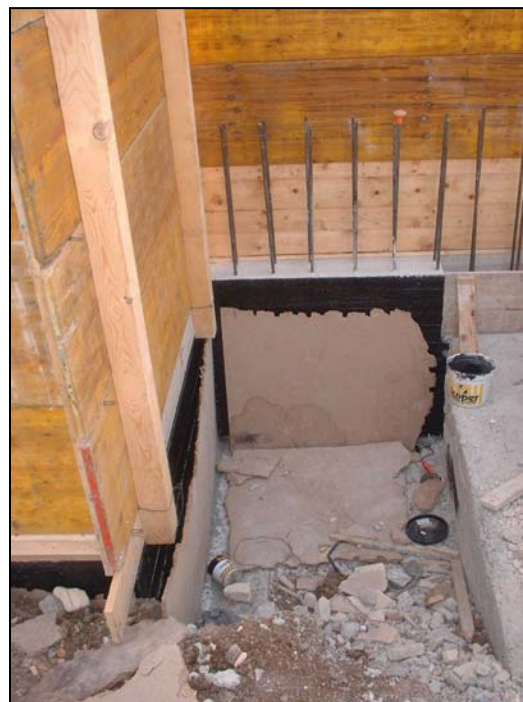
Icofer controterra e strato di protezione
