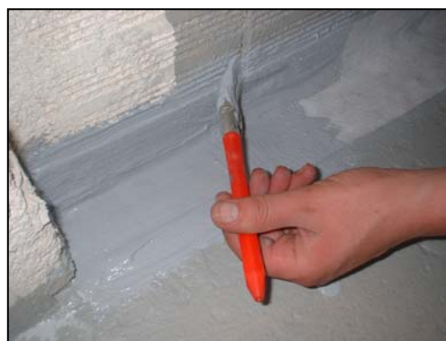
Rinforzo angolo parete-pavimento
